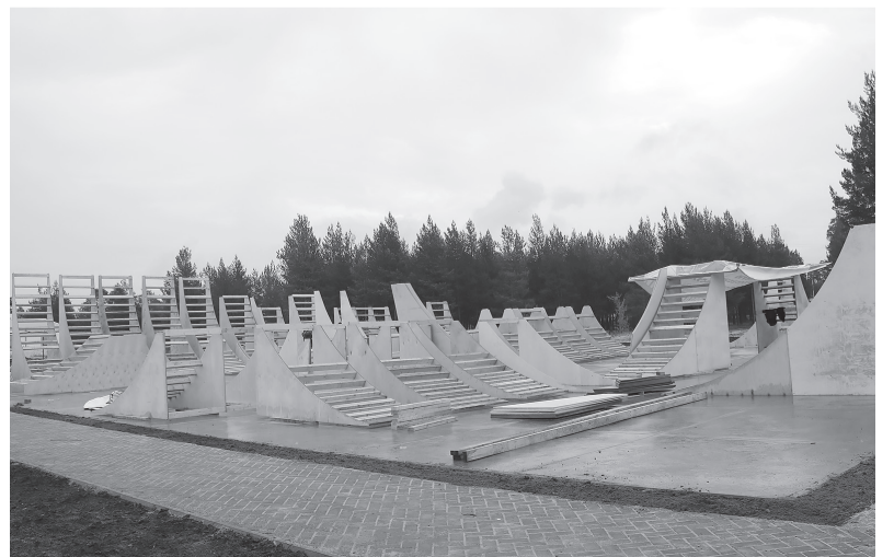
Сейчас идёт монтаж оборудования скейт-площадки для экстремальных видов спорта
