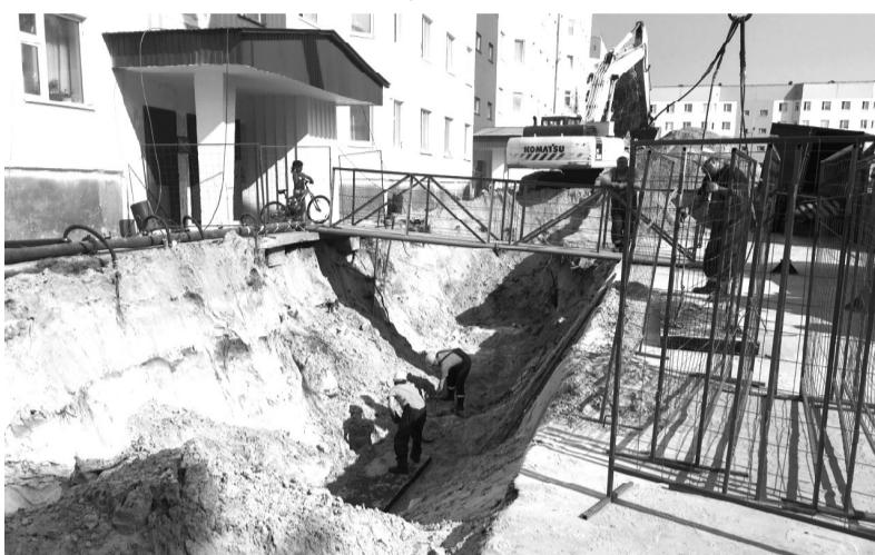
Рабочие производят замену канализационных коллекторов и трубопроводов. Глубина, на которой проводятся работы, составляет 4 метра.
