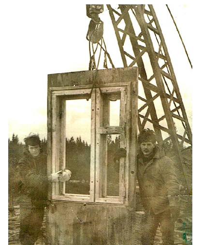
Строительство первой двухэтажки.
