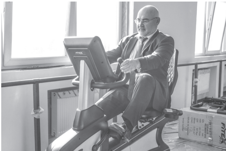
В спорткомплексе уже устанавливают тренажеры ФОТО ДАУДА БАТЫЖОВА
