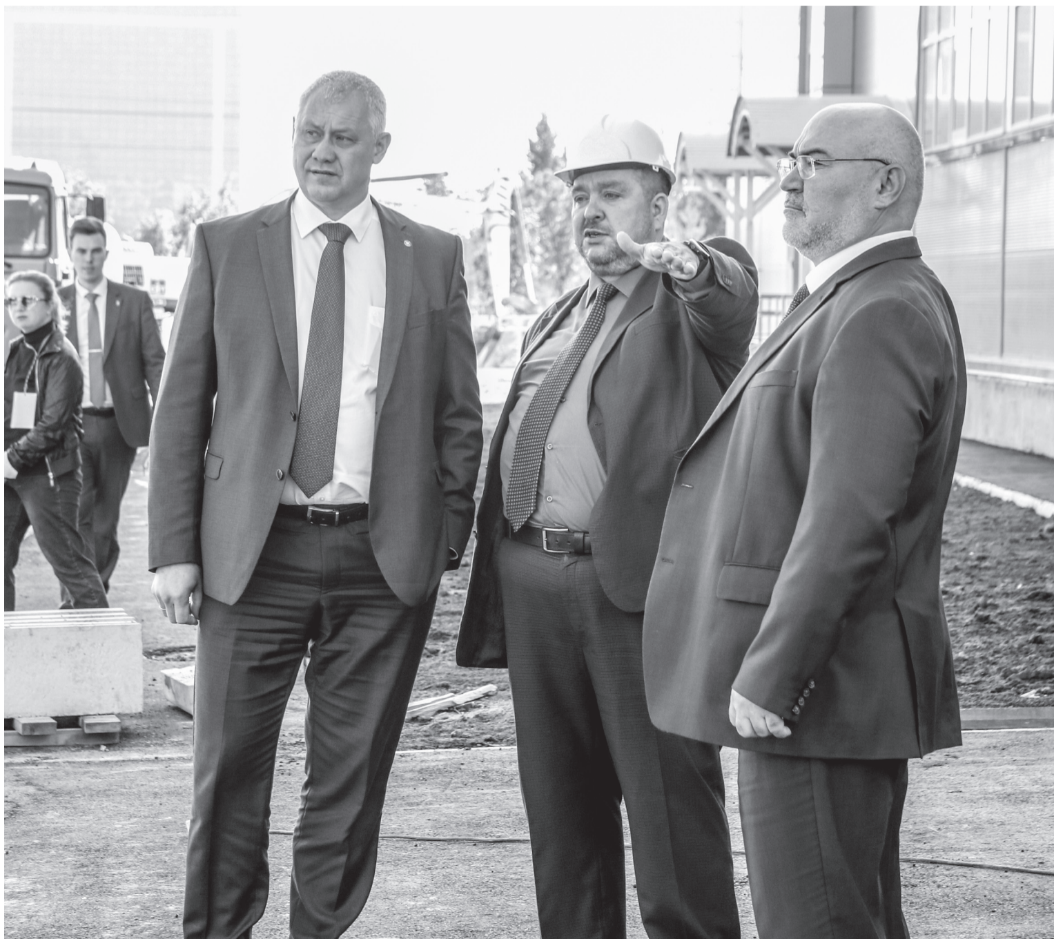
■ Глава города Владимир Степура, генеральный директор ТПП «Покачевнефтегаз» Сергей Шишкин и заместитель главы города Наиль Вафин на строительстве нового спортивного комплекса / ФОТО ДАУДА БАТЫЖОВА
