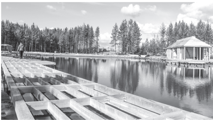
Строительство объекта «Тёплый берег» - на постоянном контроле у главы города / ФОТО ЮЛИИ МЕЛЬНИК
