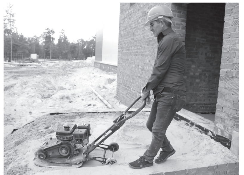
Так проводится устройство песчаной подготовки под железобетонные полы
