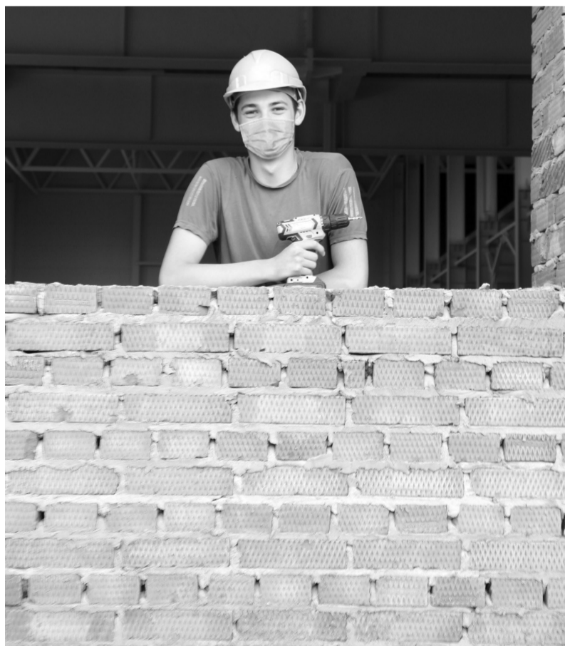
На строительстве спорткомплекса
