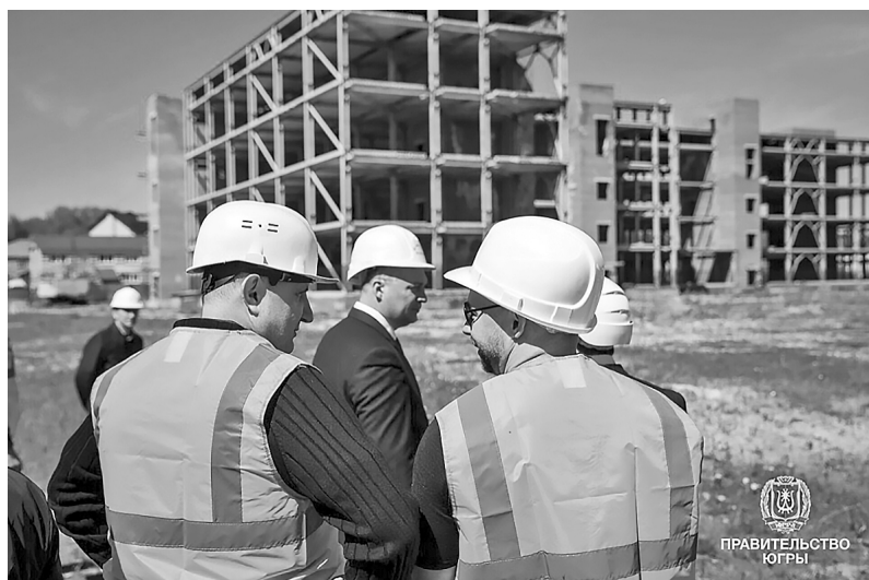
Подрядчик уже начинает работы на стройке Горноправдинской больницы
